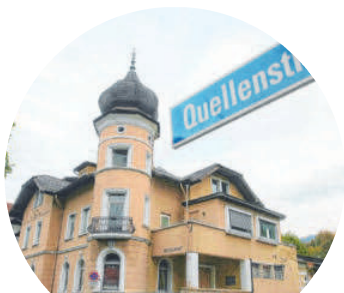
Die Quellenstraße wird ab kommenden Montag erneuert.
